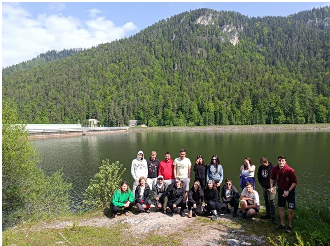
Dolná nádrž prečerpávacej vodnej elektrárne Čierny Váh postavená na rovnomennej rieke (foto: L. Eštok)
